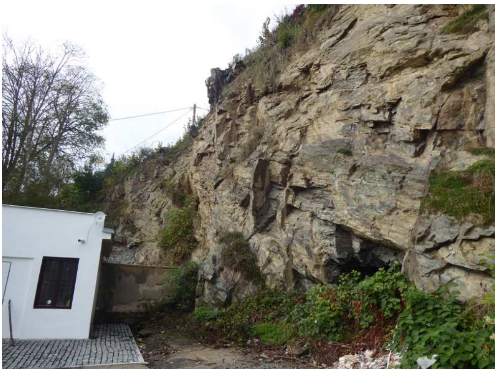
Po odstranění vegetace, očištění, odtěžení a obnově akumulčního prostoru bude část skalního svahu zajištěna kotvenou ocelovou sítí 80 x 100 mm, částečně doplněnou (podloženou) protierozní extrudovanou PP georohoží.
