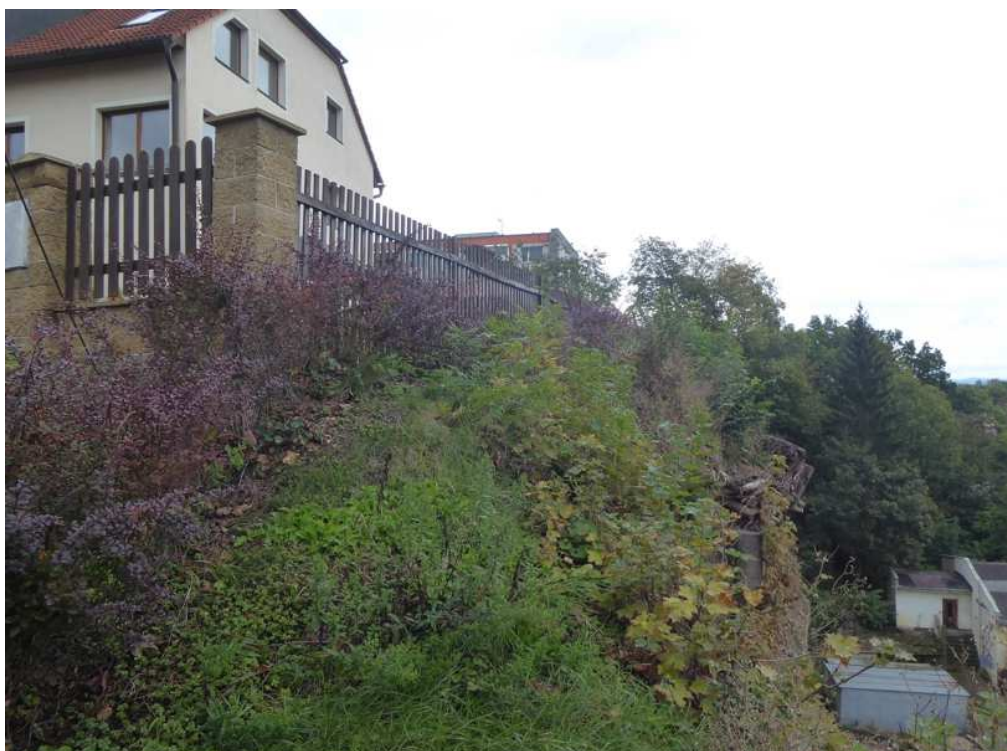
Přístup k horní hraně skalního svahu. Vzrostlá vegetace a stávající pařezy budou mechanicky odstraněny pomocí horolezecké techniky.
