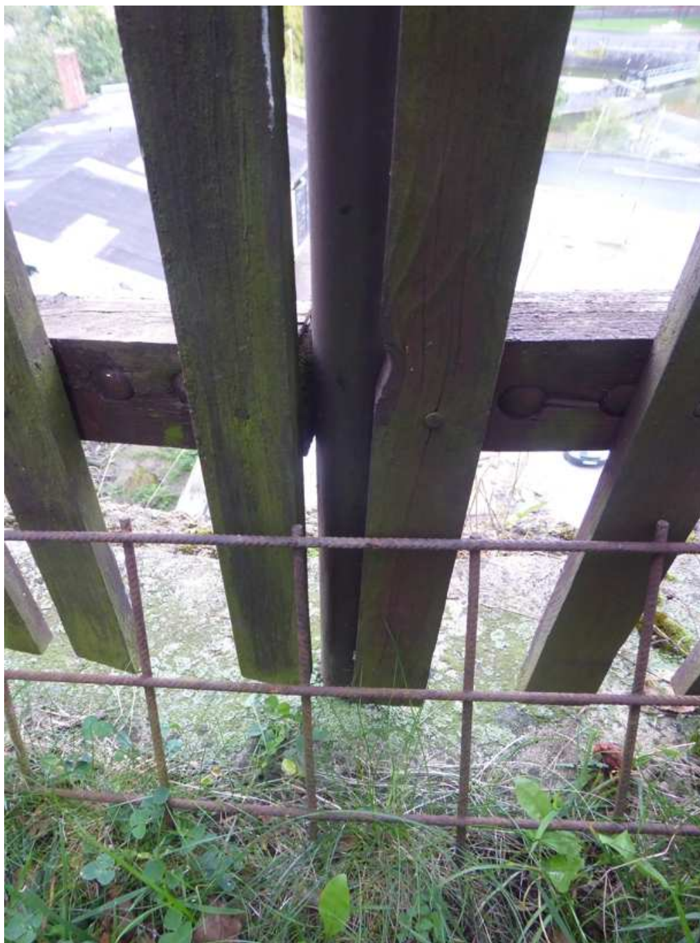
Konstrukční detail latkového plotu za horní hranou skalního svahu. V rámci stavby bude plot dočasně, částečně demontován a uskladněn v rámci staveniště. V závěru stavby bude demontovaná část oplocení znovusestavena do původní polohy z původních dílů. Všechny sloupky budou navařeny zpět do původních pozic a jednotlivá pole výplně budou opět ručně namontována.
