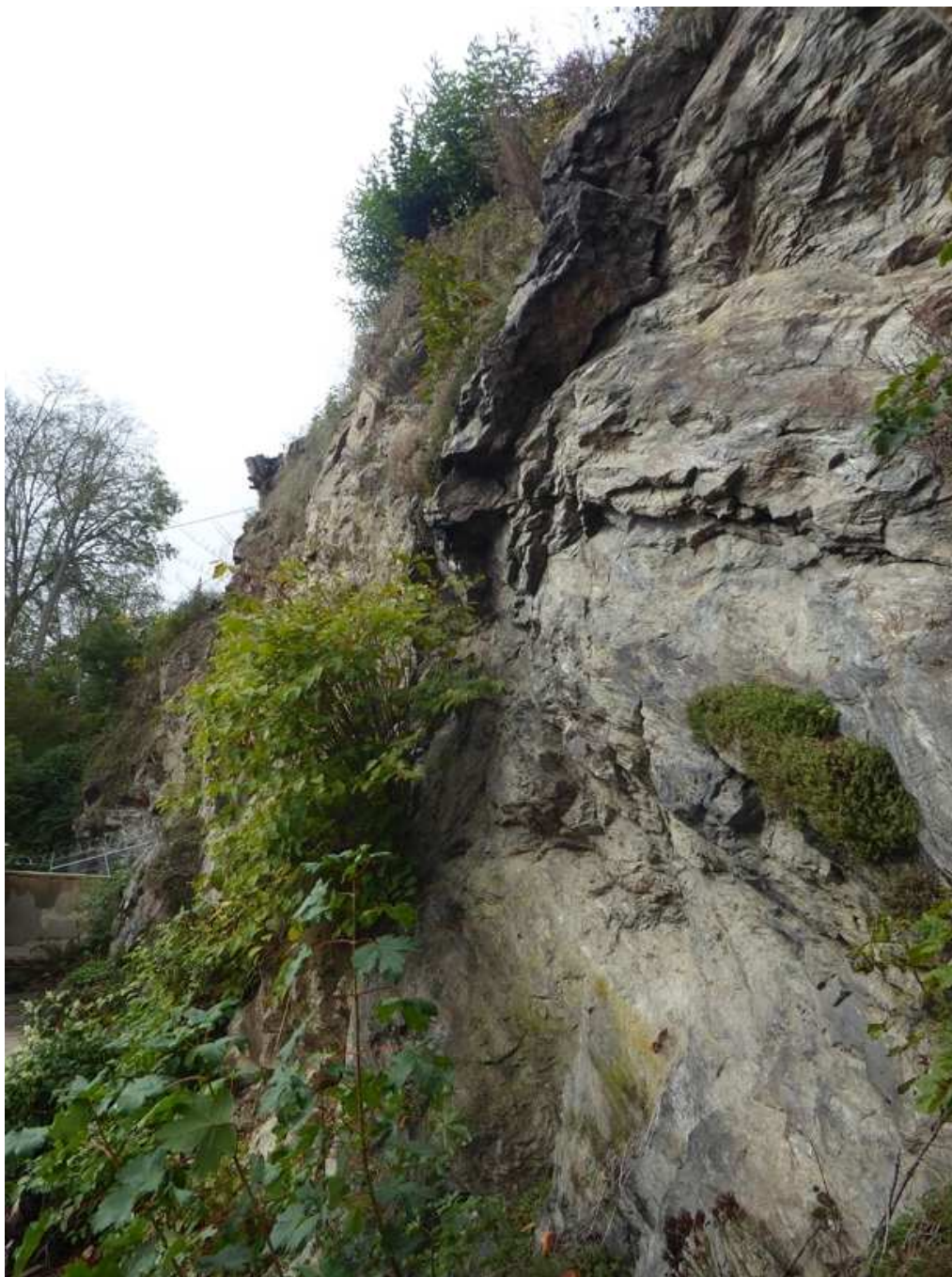
Detailní pohled na stav skalního masivu. Po odstranění vegetace, očištění, odtěžení a obnově akumulačního prostoru bude část skalního svahu zajištěna kotvenou ocelovou sítí 80 x 100 mm, částečně doplněnou (podloženou) protierozní extrudovanou PP georohoží.
